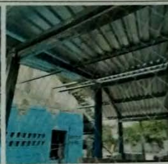
Foto 2: MODULO DE COCINA, Vista exterior de cubierta de lamina troquelada cal 26, con estructura de metal a base de costaneras, mas cerramiento de malla metalica cal 12.
