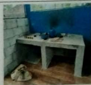
Foto 10: MODULO DE COCINA, Vista exterior de cubierta de lámina troquelada cal 26, con estructura de metal a base de costaneras, instalación de piso cerámico. Ejecución de mueble de concreto.
