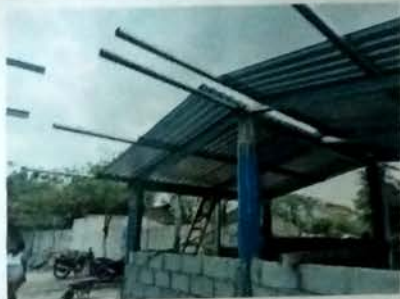
Foto 3: MODULO DE COCINA, Vista exterior de cubierta de lamina troquelada cal 26, con estructura de metal a base de costaneras, cerramiento de block pomez.
