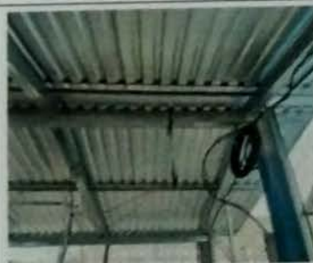
Foto 10: MODULO DE COCINA, Vista exterior de cubierta de lámina troquelada cal 26, con estructura de metal a base de costaneras, instalación de piso cerámico. Ejecución de mueble de concreto.
