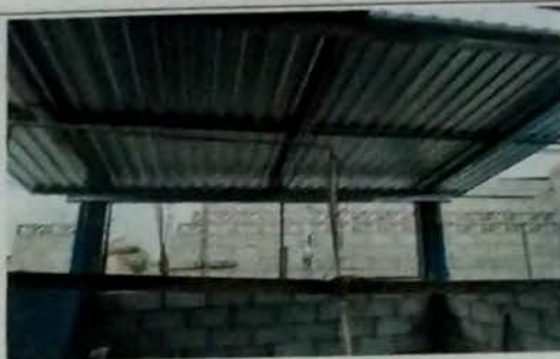
Foto 7: MODULO DE COCINA, Vista exterior de cubierta de lámina troquelada cal 26, con estructura de metal a base de costaneras
