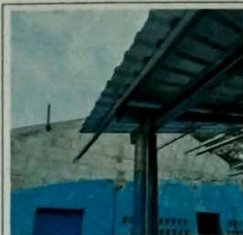
Foto 2: MODULO DE COCINA, Vista exterior de cubierta de lamina troquelada cal 26, con estructura de metal a base de costaneras, mas cerramiento de malla metalica cal 12.
