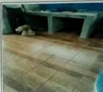
Foto 9: MODULO DE COCINA, Vista exterior de cubierta de lámina troquelada cal 26, con estructura de metal a base de costaneras, instalación de piso cerámico. Ejecución de mueble de concreto, mas instalación de pila.
