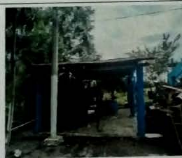
Foto 4: MODULO DE COCINA, Vista exterior de cubierta de lamina troquelada cal 26, con estructura de metal a base de costaneras, cerramiento de block pomez.
