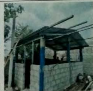
Foto 4: MODULO DE COCINA, Vista exterior de cubierta de lamina troquelada cal 26, con estructura de metal a base de costaneras, cerramiento de block pomez.
