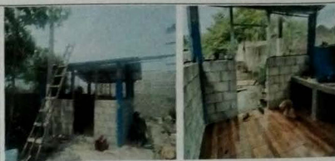
Foto 8: MODULO DE COCINA, Vista exterior de cubierta de lámina troquelada cal 26, con estructura de metal a base de costaneras, instalación de piso cerámico.
